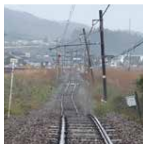
宝達志水町敷浪での線路の沈下 〔提供: 今井様〕
