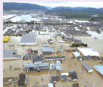
平成 30 年 7 月豪雨災害 (岡山県倉敷市真備町) 〔写真提供: 和田様〕
